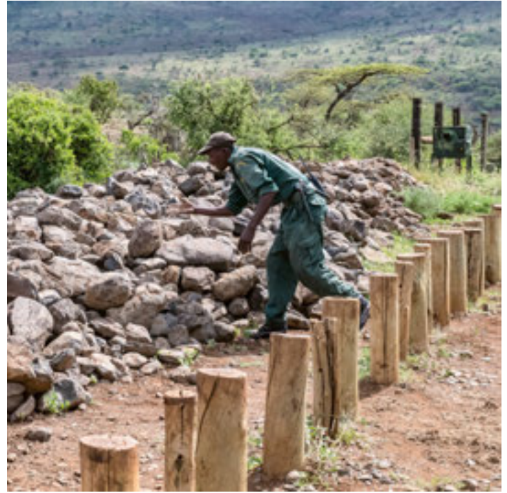
Durchgang erlaubt – aber nicht für alle. Die Schleusen in die und aus den Reservaten sind so gebaut, dass Elefanten, Zebras und andere sie passieren können. Nur das Nashorn kann nicht an den Baumstämmen vorbeischlüpfen.
